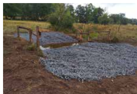
● Aménagement d'un passage à gué
