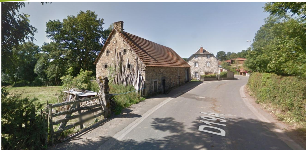
FIGURE 60 : A GAUCHE : MAISON REMARQUABLE A MONTEL-EN-GELAT EN ETAT DE QUASI RUINE. A DROITE, ANCIENNE ANNEXE AGRICOLE ABANDONNEE (ON APERÇOIT AU FOND A DROITE LES BATIMENTS AGRICOLES MODERNES ET MESURE LEUR IMPACT PAYSAGER)
