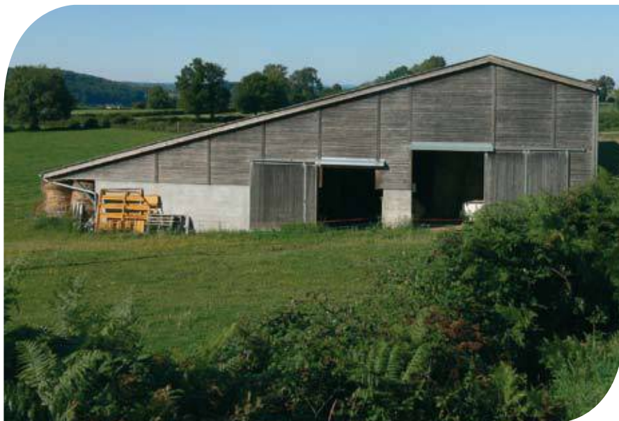
Bâtiment bois avec une forme adaptée au talus.
