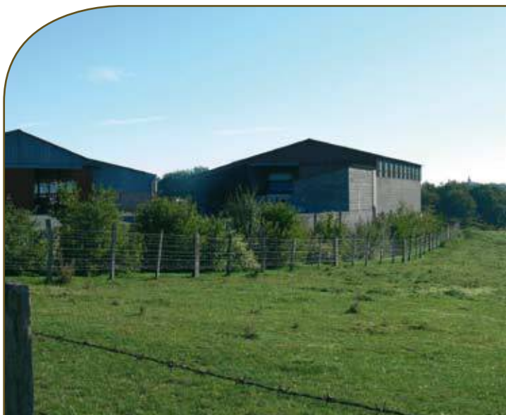
Plantation d'une baie diversifiée le long d'un bâtiment.
