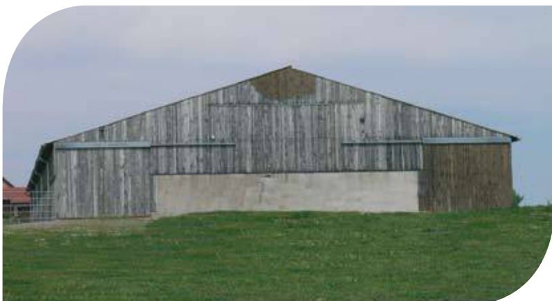
Bardage en cours de traitement.
